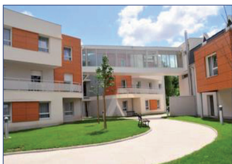
Chambray-les-Tours (37) : EHPAD de 86 lits
