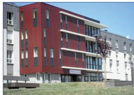
Montivilliers (76) : EHPAD de 92 lits
